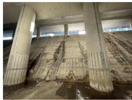
地下1階から撮影。危険水位を超えると水が流れる。
